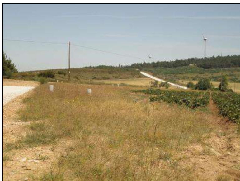
Foto 2. 6 – Vala de grandes dimensões para instalação de cabo (ao longo da berma direita de acesso) cerca de um ano após recuperação
