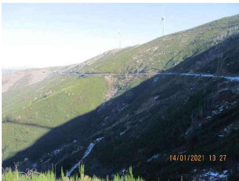
Foto 2. 27 – Vista para corredor da linha elétrica aérea (pormenor Outeiro do Carvalho)
