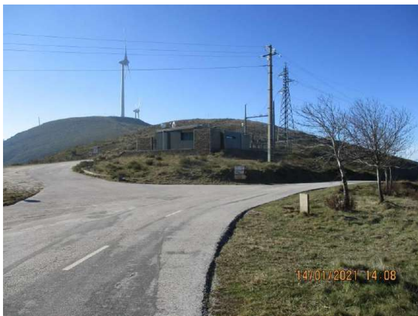
Foto 2. 18 – Subestação do Parque Eólico de Serra do Açor
