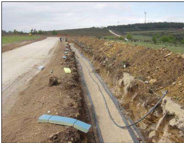
Foto 2. 5 – Vala para instalação de cabo (ao longo da berma direita de acesso)
