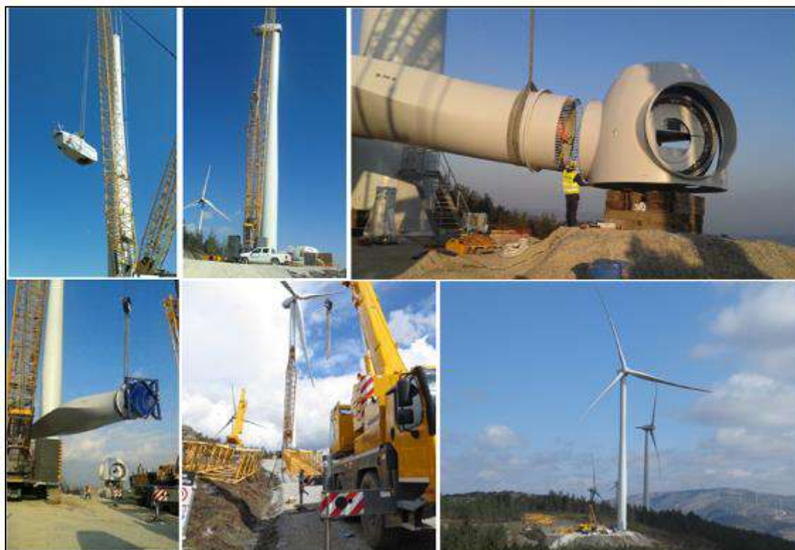
Foto 2. 4 – Aspetos da montagem do rotor
