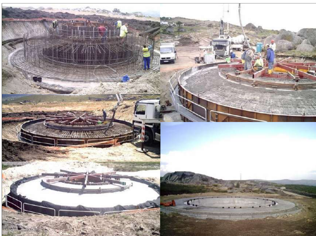
Foto 2. 3 – Evolução da construção da fundação
