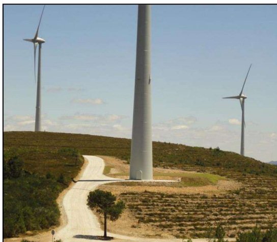
Foto 2. 1 – Plataforma dos aerogeradores
