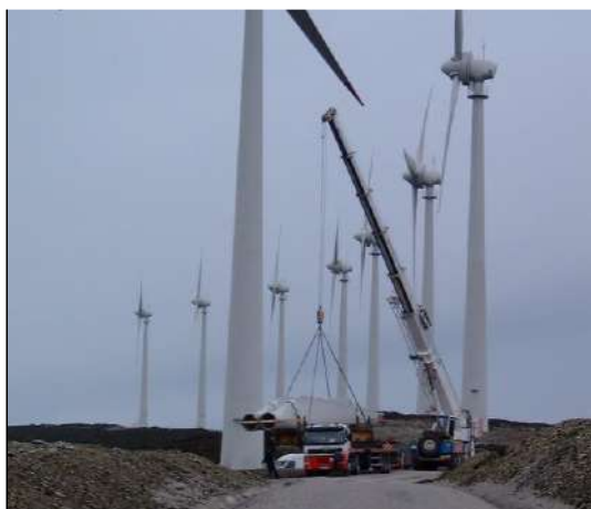
Foto 2. 2 – Acesso do parque utilizado como plataforma para realização de manutenção
